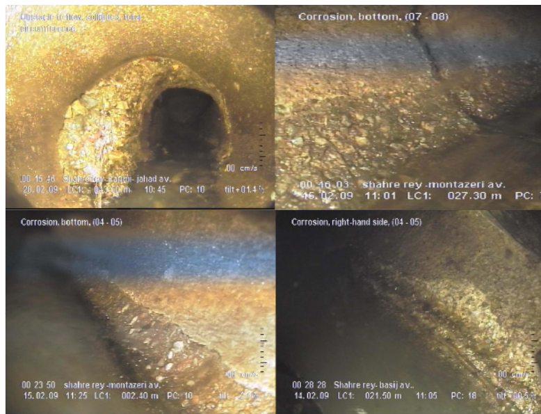
شکل ۴- نمونه از خوردگی های موجود در شبکه جمع آوری فاضلاب شهری که توسط سیستم تلویزیون مدار بسته در حین بررسی بصری شبکه گرفته شده است
