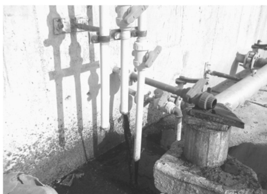
شکل ۲- شیرهای خروجی از بدنه راکتور UASB
