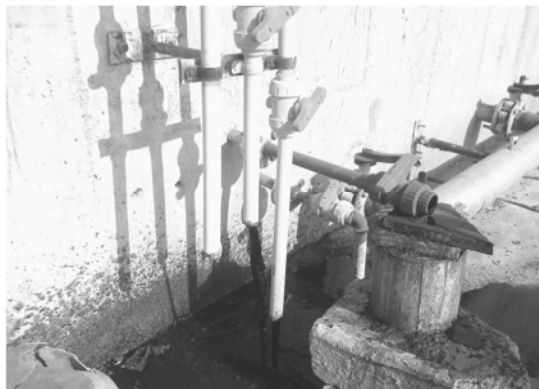
شکل ۲- شیرهای خروجی از بدنه راکتور UASB
