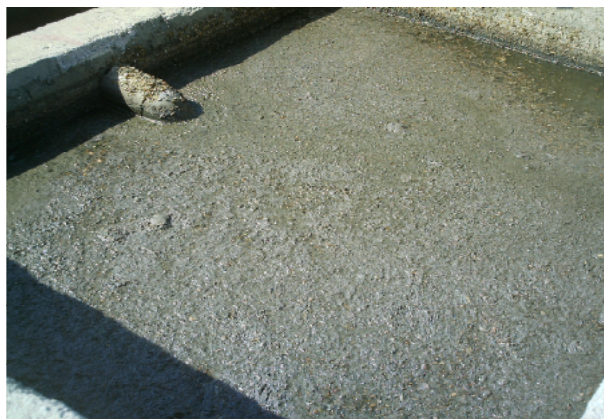
شکل ۲- تجمع چربی، روغن و لجن در سطح هاضم بی‌هوایی
