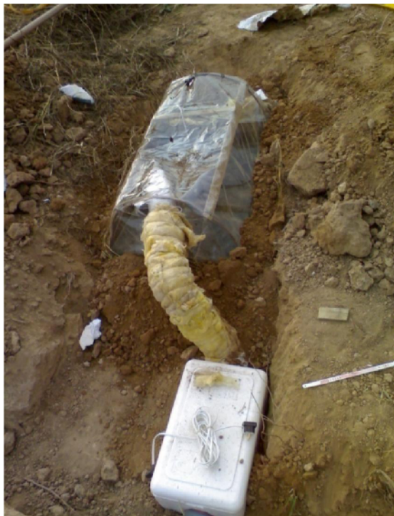
شکل ۴- آماده‌سازی مخزن دستگاه تقطیر و قسمت مکش دستگاه
