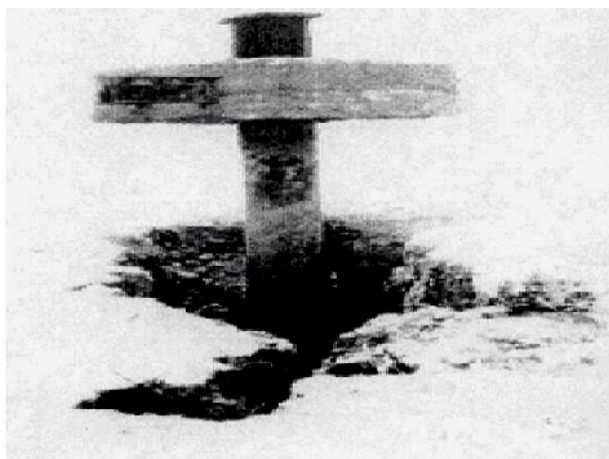
شکل ۱- الف- نشست زمین پیرامون لوله جدار یک چاه آب در دشت رفسنجان [۲۵]
