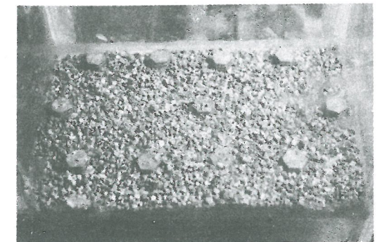
شکل ۳- شمای کف بستر شامل بستر نگهدارنده و نازل‌های خروج آب فیلتر شده به منطقه آب شفاف
