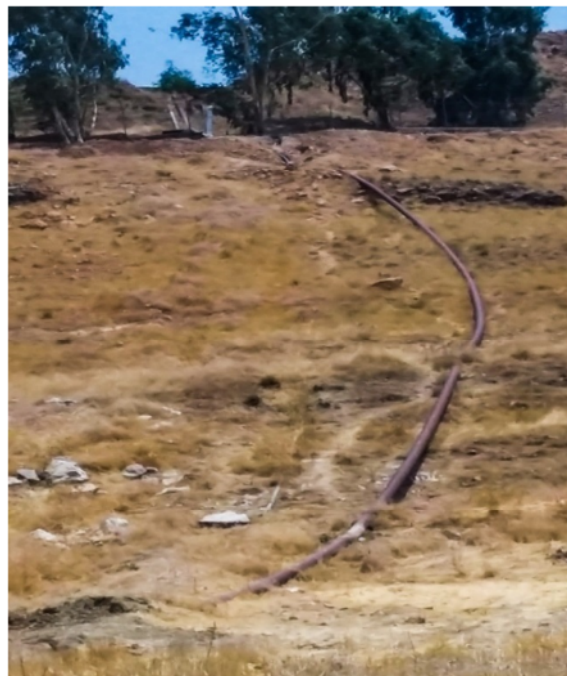
Fig. 8. Surfaced steel transfer line شکل ۸- خط انتقال روکار فولادی
